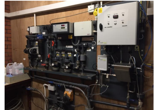
MS1200 installato in un potabilizzatore
